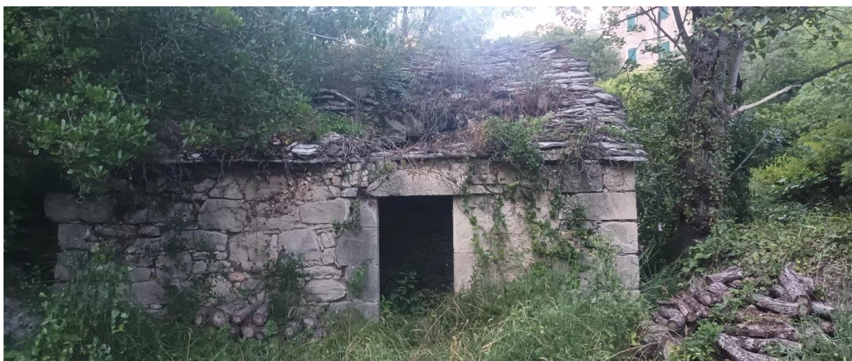
Photo 1 : Vu du moulin face avant (exposition nord)
